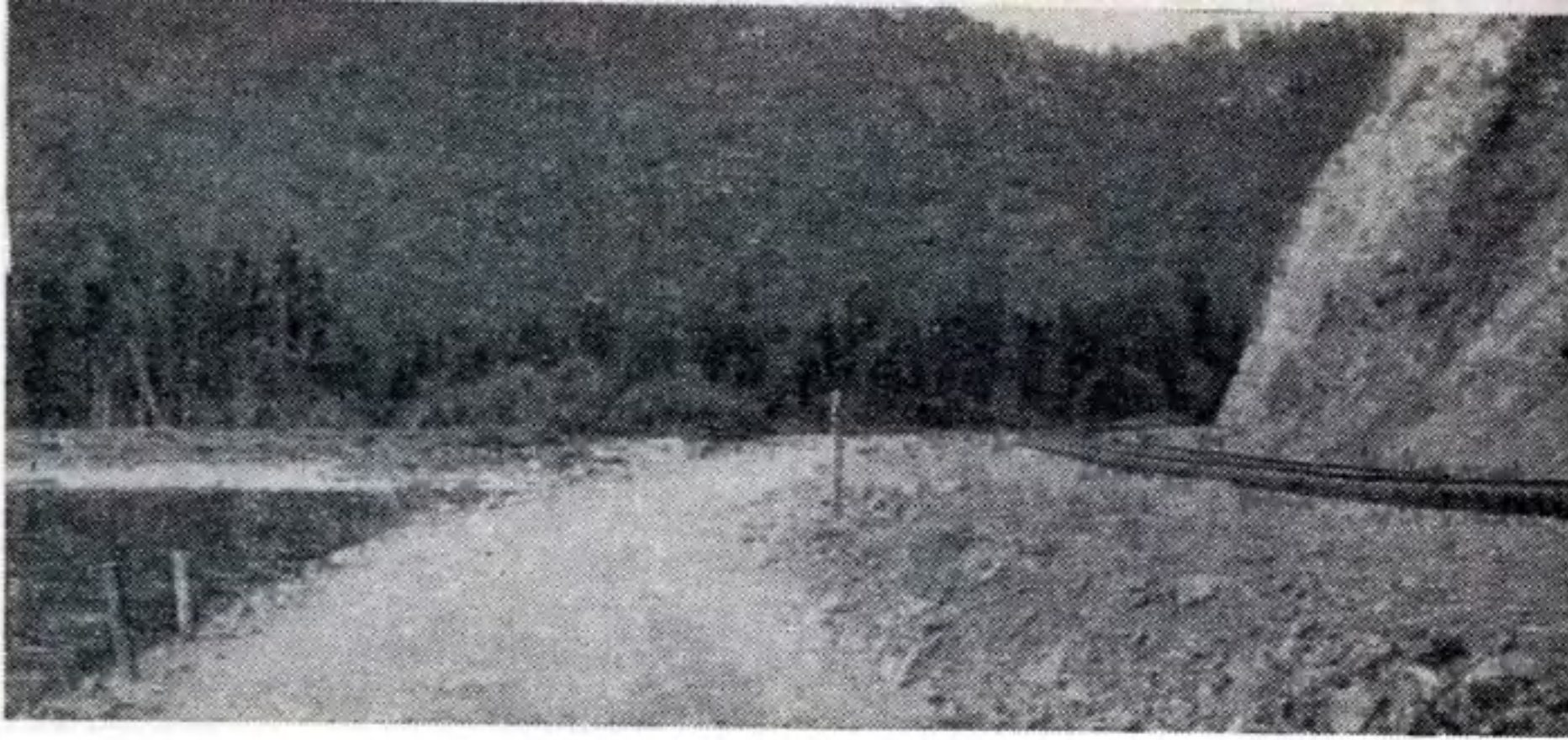
А здесь уже легли рельсы.
